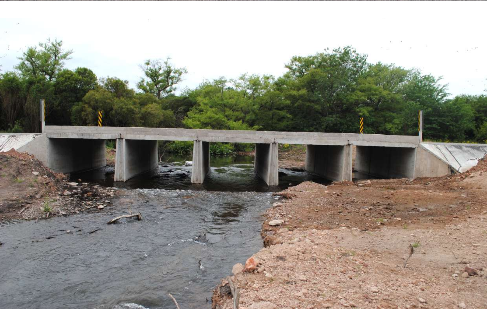
PASO PIEDRA SOBRE ARROYO VIBORAS - Colonia. 8 Alcantarillas Tipo CL1 (2016)
