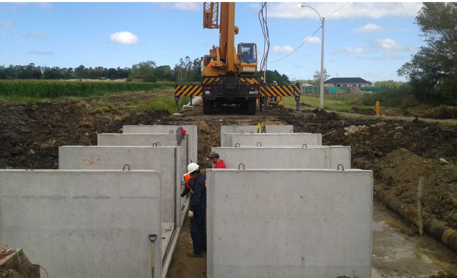
PUENTE LA TAHONA - Ruta Ib. Km. 23.9, Cno. de los Horneros, Ciudad de la Costa (2013)
