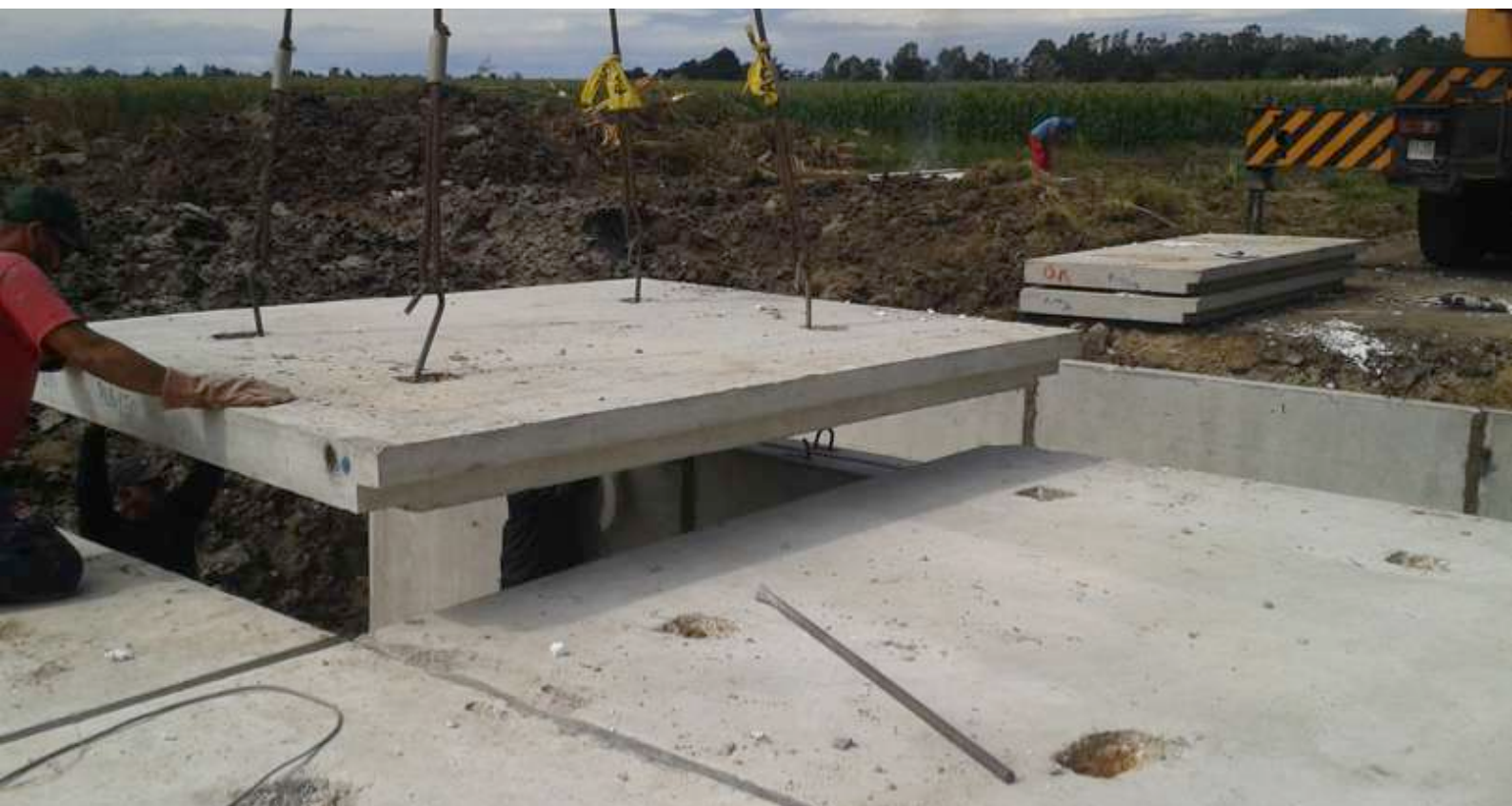
PUENTE LA TAHONA - Ruta Ib. Km. 23.9, Cno. de los Horneros, Ciudad de la Costa (2013)
