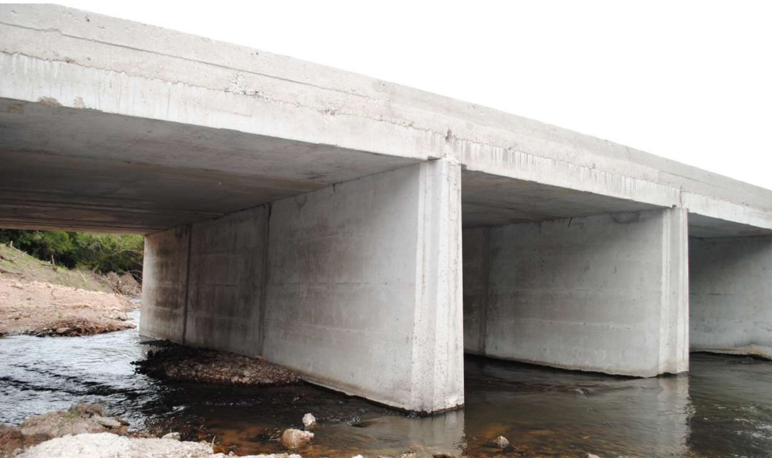
PASO PIEDRA SOBRE ARROYO VIBORAS - Colonia. 8 Alcantarillas Tipo CL1 (2016)
