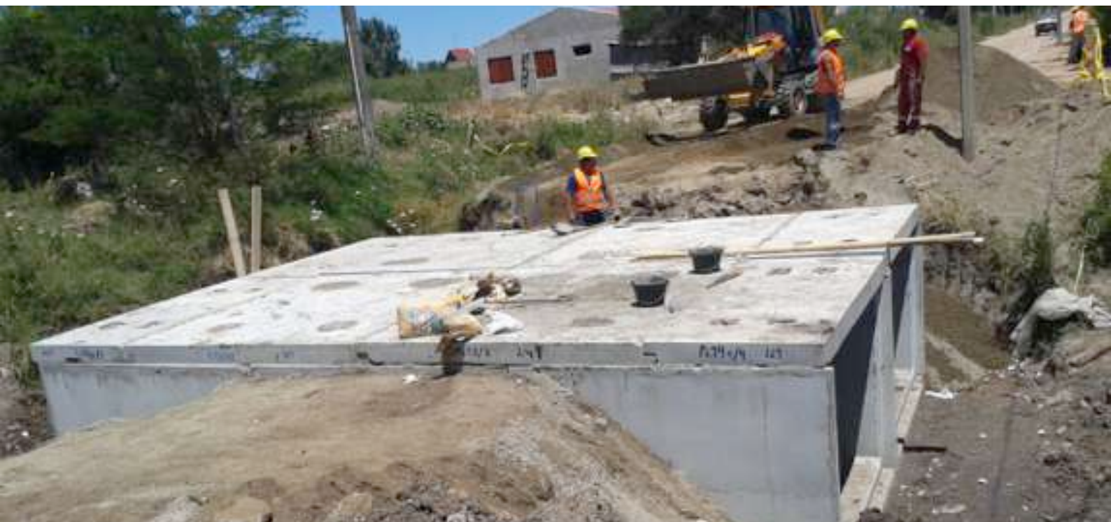
CALLE CENDÁN - Puente sobre Cañada de Los Pescadores. Hasta 16, 5 toneladas de resistencia.
